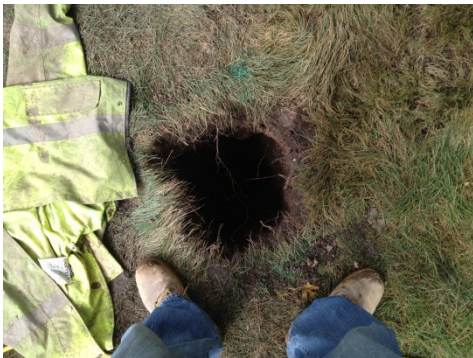
Actual photo of the lateral access hole.
